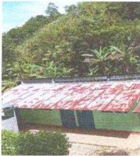
Foto 1: Sustitución de laminas modulo 1 y 2
