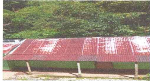
Foto 2: Sustitución de estructura de soporte por metal, modulo 2
